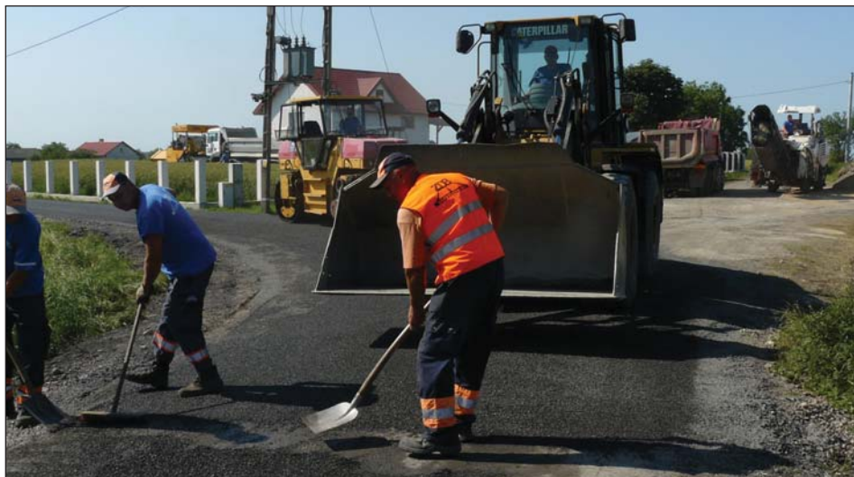
Modernizacja drogi gminnej w Nawra
